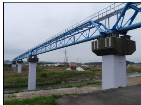
<菊川下流水管橋>
