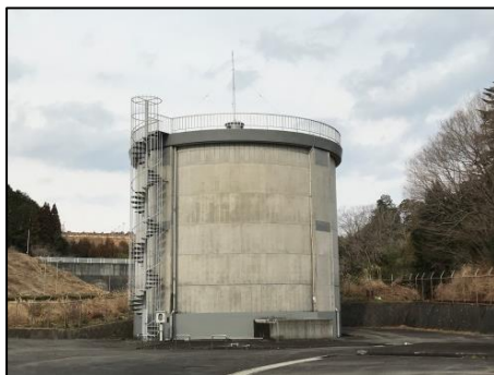
<右岸増圧ポンプ場ポンプ井>
