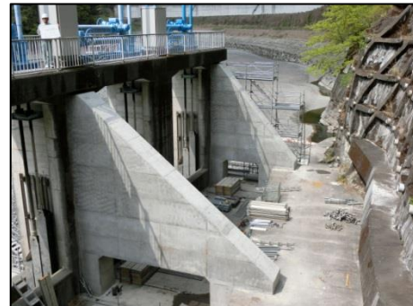
<予備取水工耐震補強工事>
