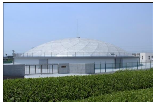
< 右岸牧之原調整池 >
