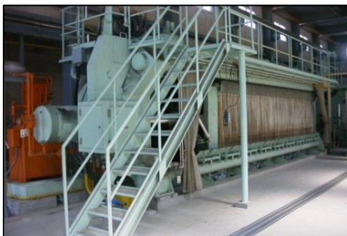
＜無薬注脱水機＞
