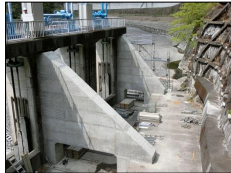
＜予備取水工耐震補強工事＞
