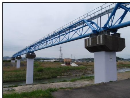
＜菊川下流水管橋＞
